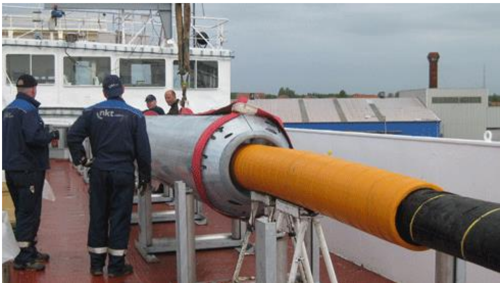
Et godt isoleret søkabel udlægges (nkt-cables)
